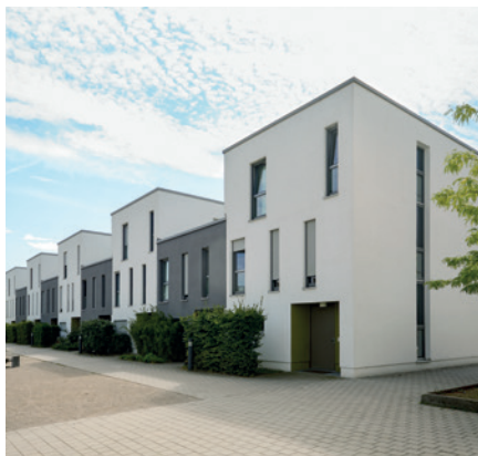
Auch als Dachinstallation hervorragend geeignet - die perfekte Wahl für Neubauten dank hoher Effizienz
