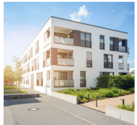
Auch als Kaskaden- oder Einzellösung pro Einheit in Mehrfamilienhäusern erhältlich
