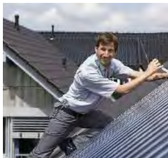
Montage von Sonnenkollektoren
